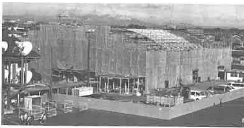
改修工事中の 体育館の様子
